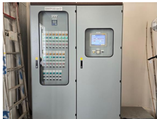
รูปที่ 2-24 ตู้ควบคุมระบบบำบัดน้ำเสีย และมิเตอร์ไฟฟ้า สำหรับระบบบำบัดน้ำเสียโดยเฉพาะ
