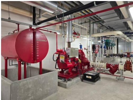
รูปที่ 2-31 ปั้มน้ำใช้และปั้มน้ำดับเพลิง
