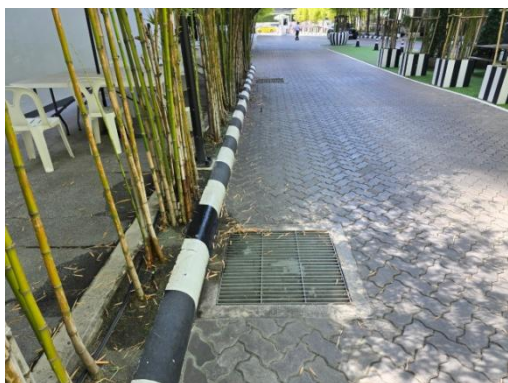
รูปที่ 2-28 ระบบรางระบายน้ำ พร้อมกั้นตะแกรงครอบ
