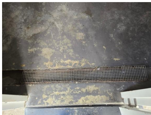
รูปที่ 2-49 ท่อรวบรวมน้ำเสียจากห้องพักขยะรวม
